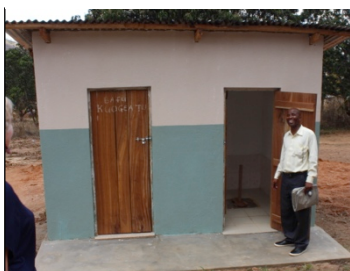
New HC toilets
